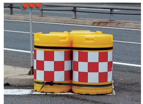
クッションドラム設置例(連結用ロープC使用)
