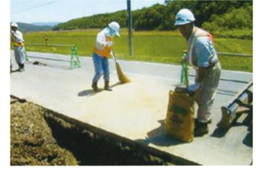
舗装に漏れた作動油に現場で備蓄していたオイルゲーターをまき、油吸着させています。
